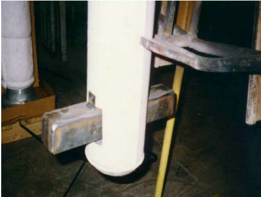
Figura 5. Direccionador de flujo instalado en una buza.
